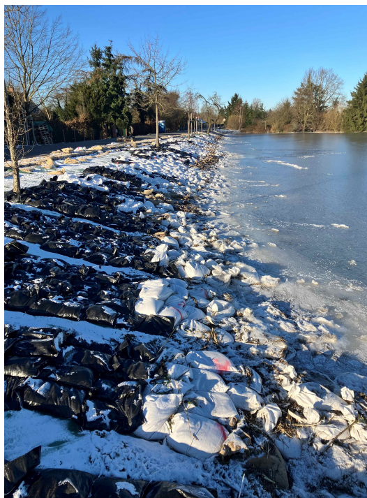
Sandsacksicherung
